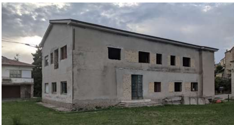
Foto della ex scuola: esterno, fronte strada
